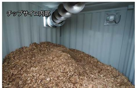
この例では、ボイラー室の20ft コンテナにチップサイロとして10ftのコンテナを連結しています。
