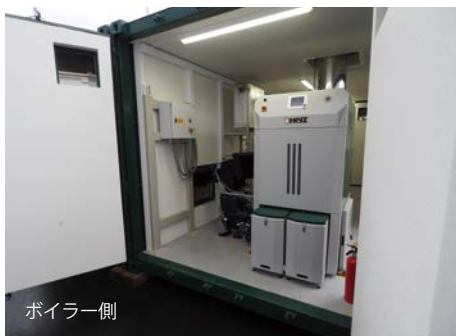
（扉を開いた状態） ボイラー室には3方向からアクセス可能 ※オプションドアを含む
