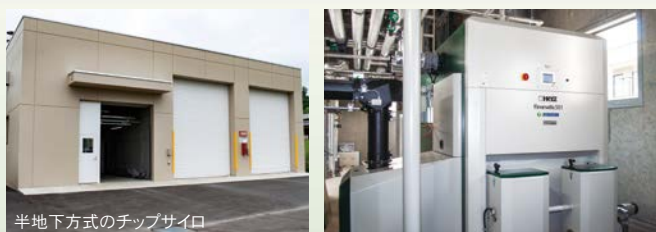
【型 式】 firematic501×2台 【設置先】 特別養護老人ホーム三笠市ことぶき荘 様 【用 途】 高齢者福祉施設の暖房・給湯用
