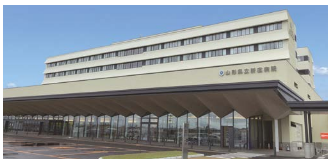
【型 式】 firematic 80×1台 【設置先】 山形県立新庄病院 様 【用 途】 施設の給湯
